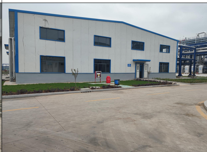
换热站、空氮站
