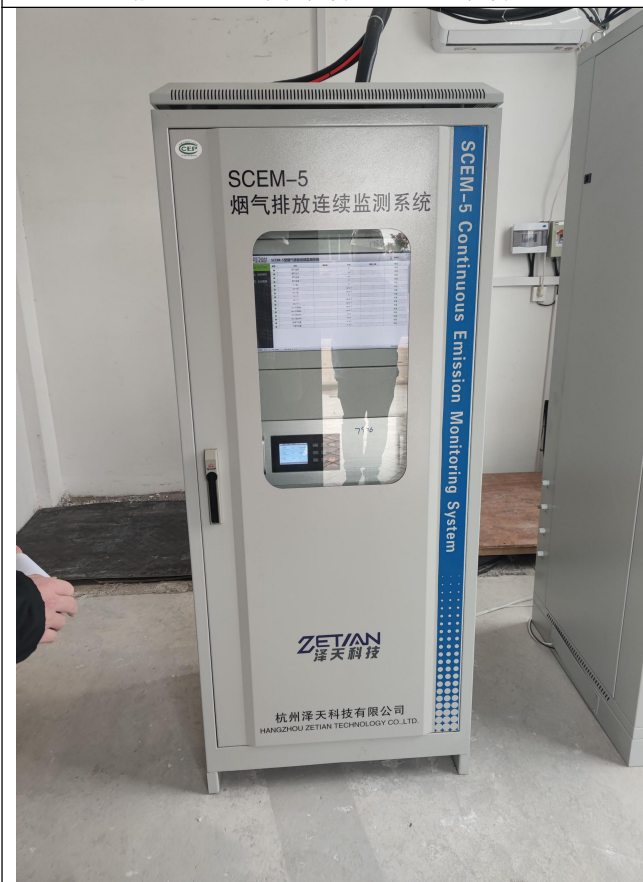
焚烧炉排气筒烟气自动检测设备
