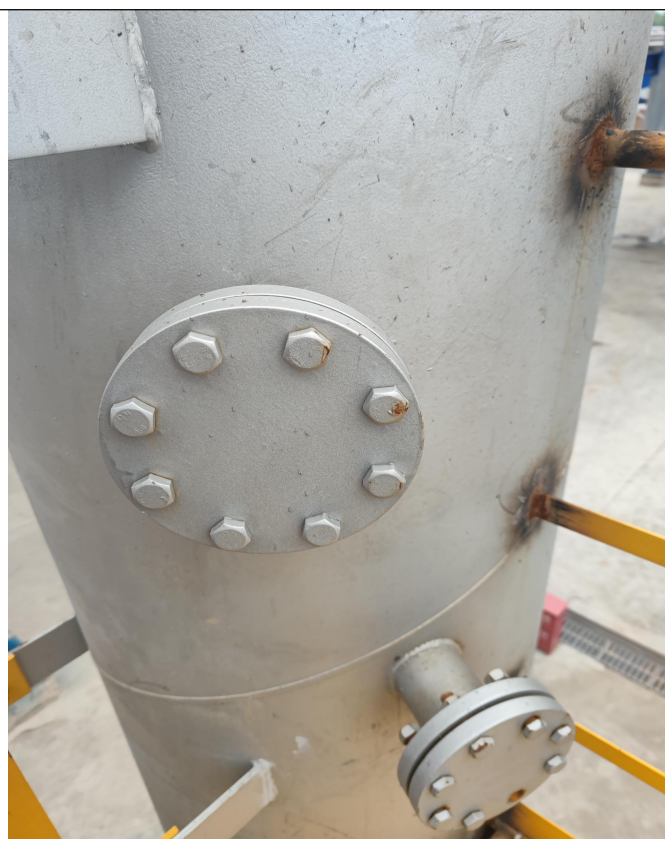
导热油炉排气筒采样口
