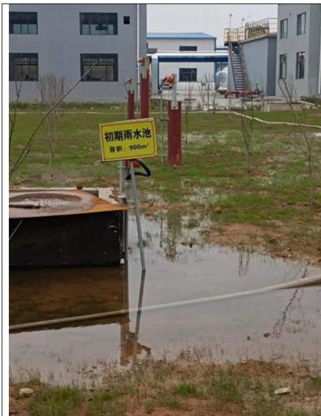
初期雨水收集池
