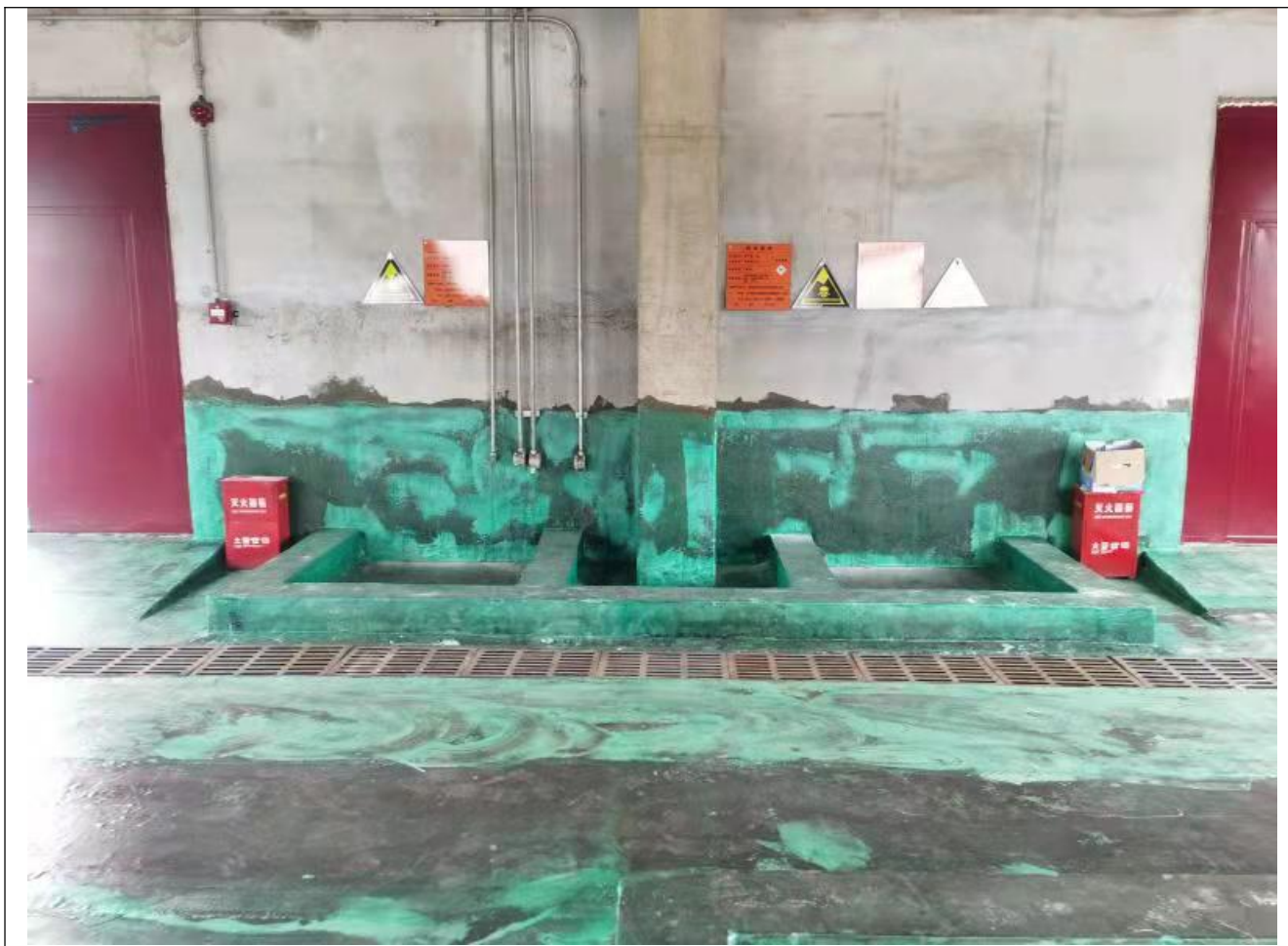
危废暂存间现状及防渗建设情况
